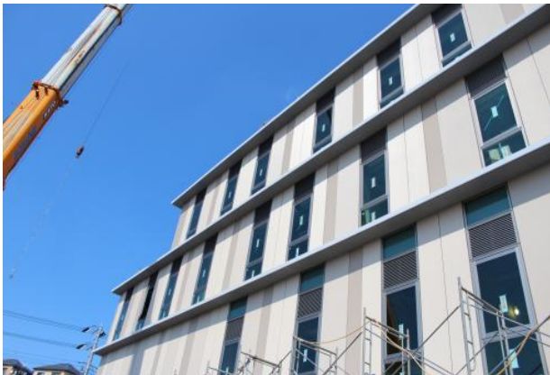
覆いと足場がとれました。(平成 26 年 4 月 24 日)
